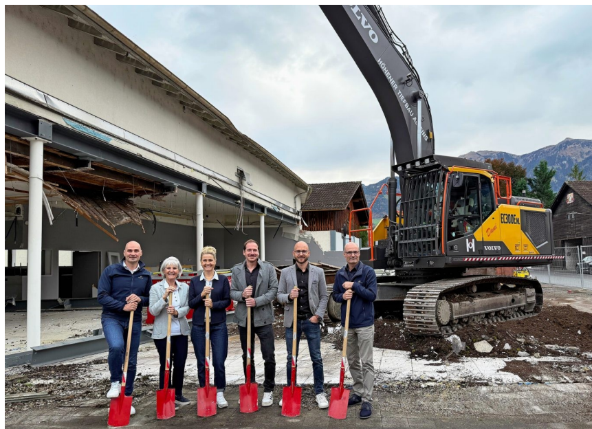
Spatenstich beim Neubauprojekt an der Brüningstrasse in Sarnen, ehemals Autohaus Sidler.
