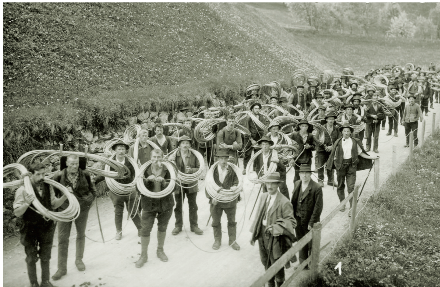
Seiltransport für die Luftseilbahn Dallenwil – Niederrickenbach.
