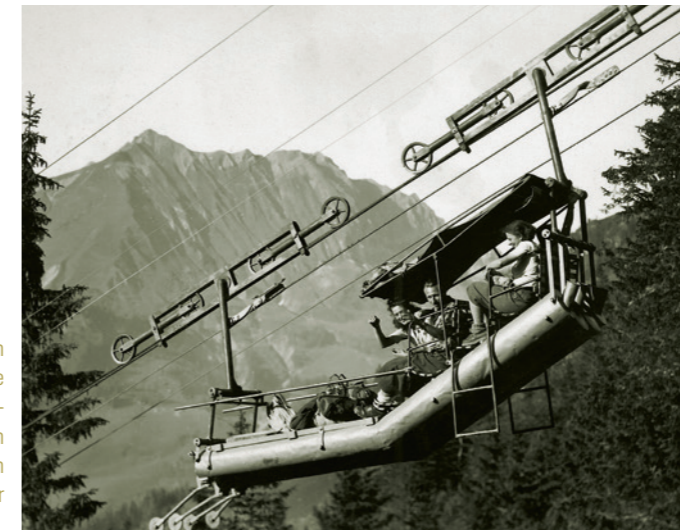
Die Luftseilbahn Bannalp funktionierte zu Beginn mit Wasserballastantrieb – davon zeugen die dicken Rohre unter der «Kabine».
