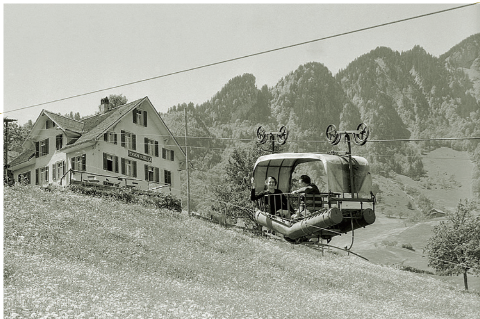
Eine weitere frühe Luftseilbahn mit Wasserballastantrieb.
