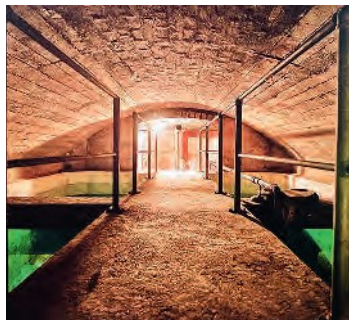
Blick ins Wasserreservoir
