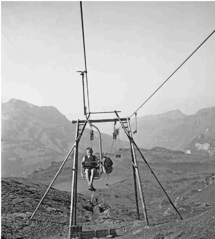
Der erste Sessellift der Schweiz: Ab 1944 konnten Wanderer in Einersesseln oder tonnenförmigen Stehkabinen vom Trübsee ob Engelberg zum Jochpass schweben.
