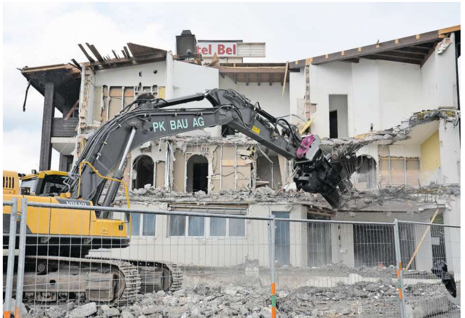
Beim Hotel Belvoir in Sachseln hat der Abbruch begonnen.
