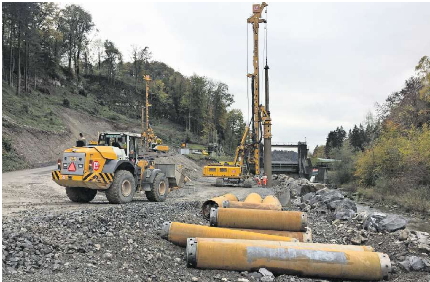
80 Tonnen schwere Grossdrehbohrgeräte stehen unterhalb des Wichelsees im Einsatz.
