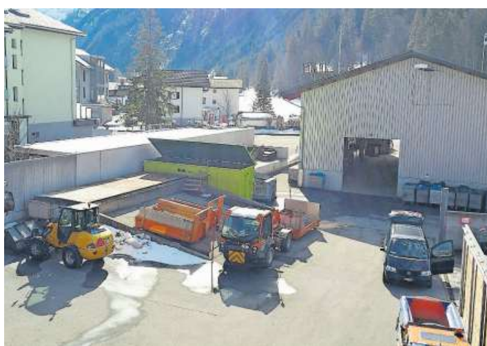
Mit zwei Bauvorhaben sollen auf dem Areal des Entsorgungshofs Wyden mehr Lagerkapazitäten geschaffen werden. Bild: PD
